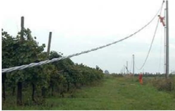
**Figura 58 - Cabo Elicord – Lançamento Condutor Isolado - Fonte Distribuidora A**
