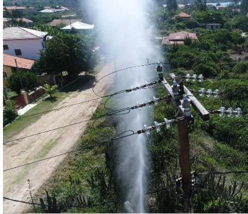
**Figura 30 - Vista superior de jateamento de água nas cadeia de isoladores - Fonte Distribuidora A**
