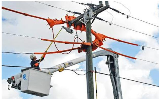
Figura 46 - Instalação do Religador automático monofásico Tripsaver - Fonte S&C Electric Company
