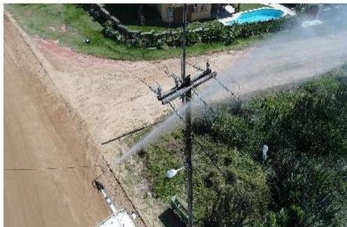
**Figura 32 - Vista lateral superior da lavagem de Rede à Distância - Fonte Distribuidora A**
