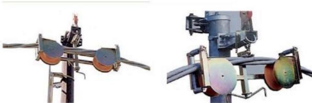
**Figura 59 - Cabo Elicord – Roldanas múltiplas estruturas passantes (suspensão) - Fonte Distribuidora A**
