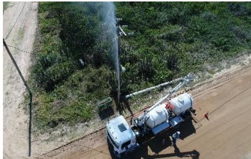
**Figura 31 - Visão Geral da Lavagem de Rede com Monitoramento à Distância - Fonte Distribuidora A**
