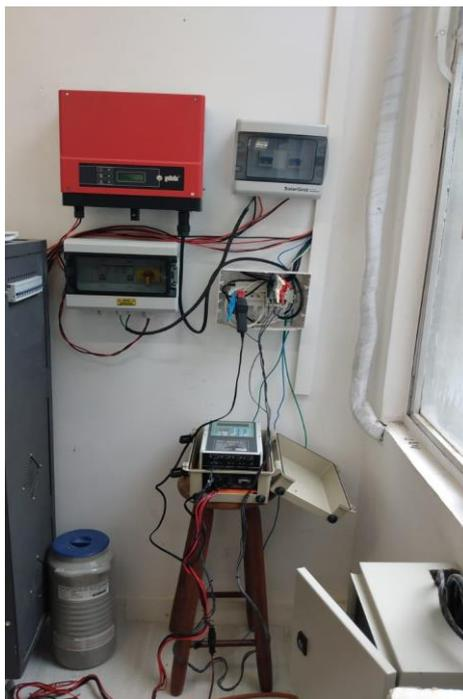
**Figura 50 – Medição do sistema conectado.**
