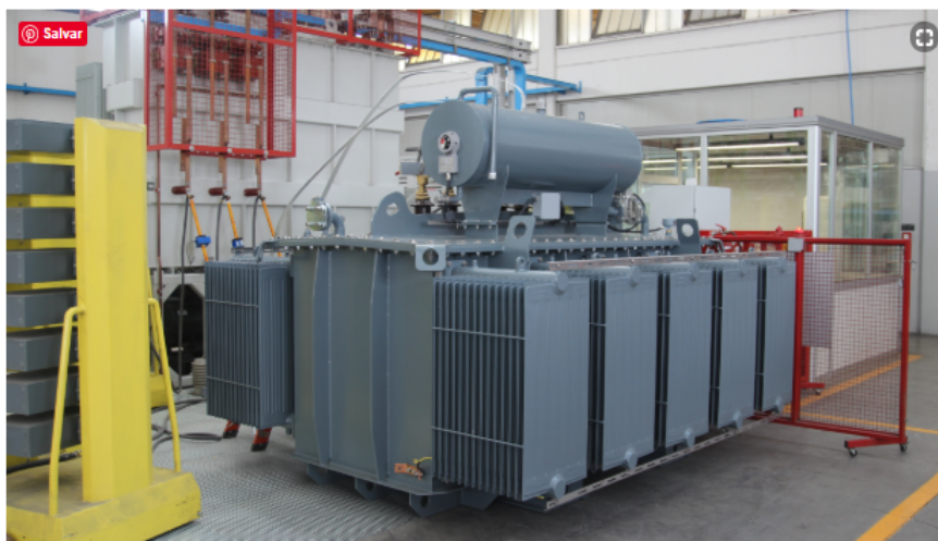
Figura 2.10: Reator imerso em um tanque de óleo. Fonte: adaptado de [46].
