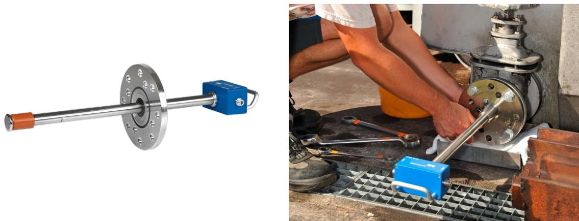
**Figura 7 – Sensor de UHF comercial, instalado no dreno do transformador a óleo (OMICRON)**
