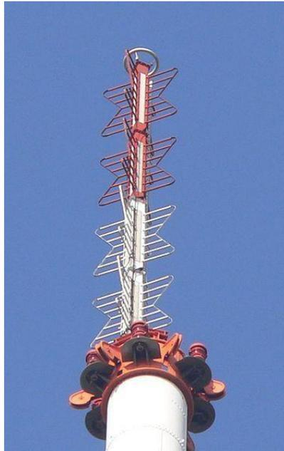
Figura 2.3: Antena *Superturnstile*, sem radome.
