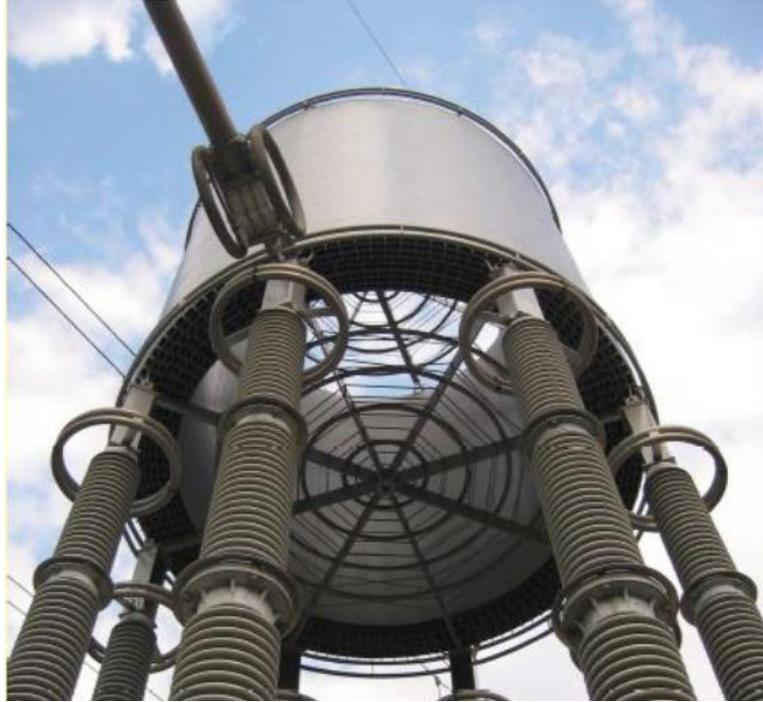
**Figura 2.2 ± Reator limitador a núcleo de ar. [10]**
