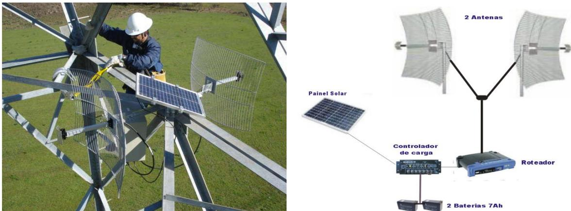
Figura 1.1 - Kit mesh desenvolvido para o projeto ReMoTe
