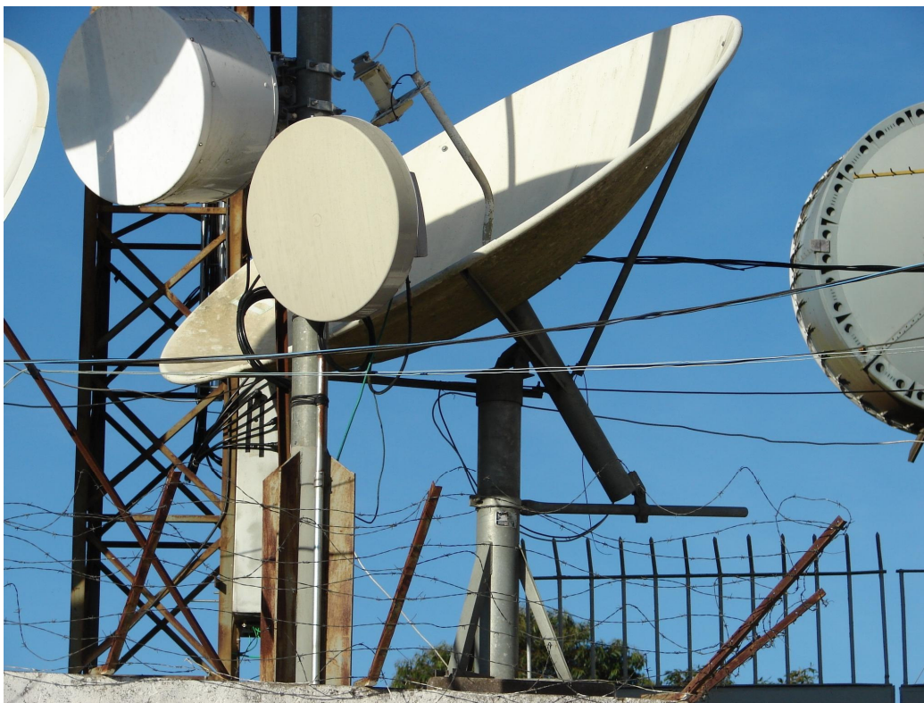
Fig. 4.3 – Estação Terrena BrasilSat operando na frequência 3556 MHz pelo satélite B1
