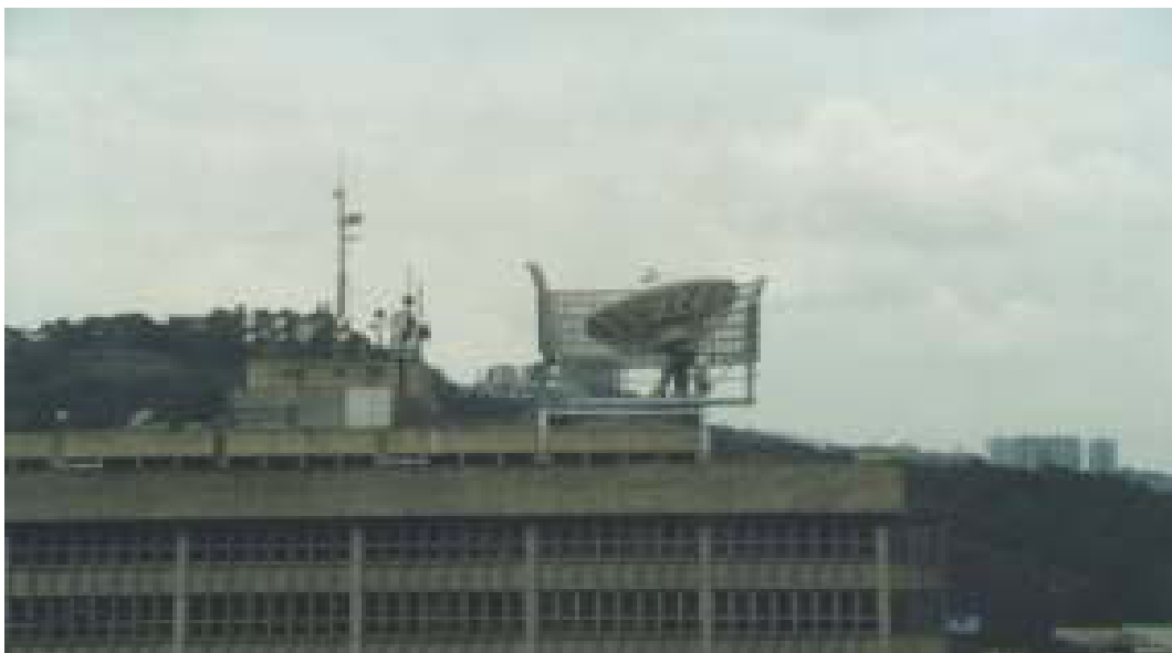
Fig. 5.3 - Estação terrena com tela de proteção, Caracas
