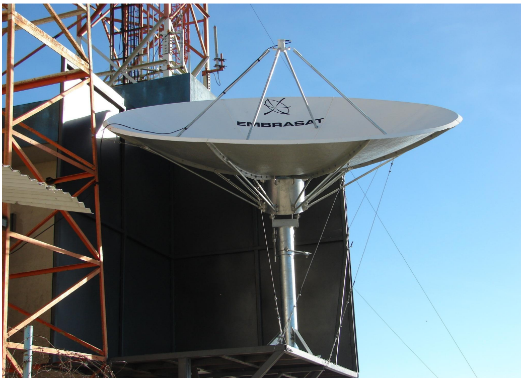
Fig.4.4– Estação terrena Embrasat operando na frequência de recepção 4038 MHz pelo satélite NSS7
