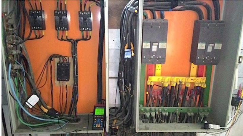
**Figura 19. Processo de medição da curva de carga bloco E UFF**
