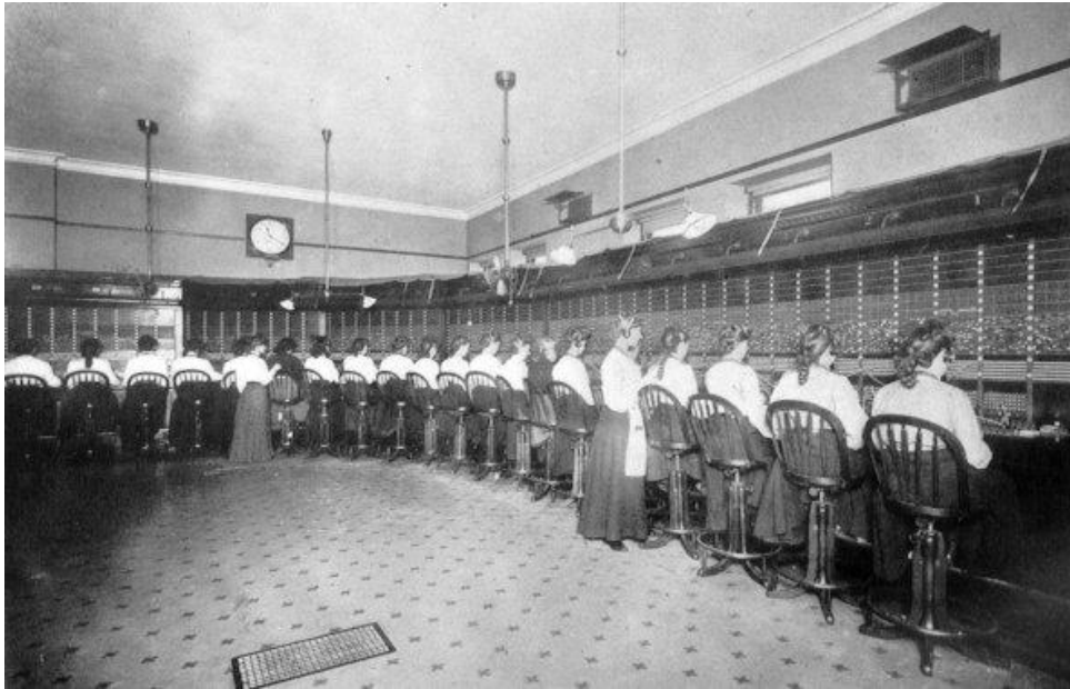
Figura 4: Centrais de comutação operadas manualmente.
