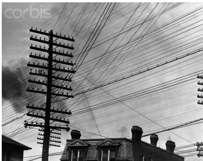
Figura 3: Cabeamento telefônico em St. Louis, Missouri, em 1900. http://www.corbisimages.com/Enlargement/Enlargement.aspx?id=IH158454&tab=details&caller=search
